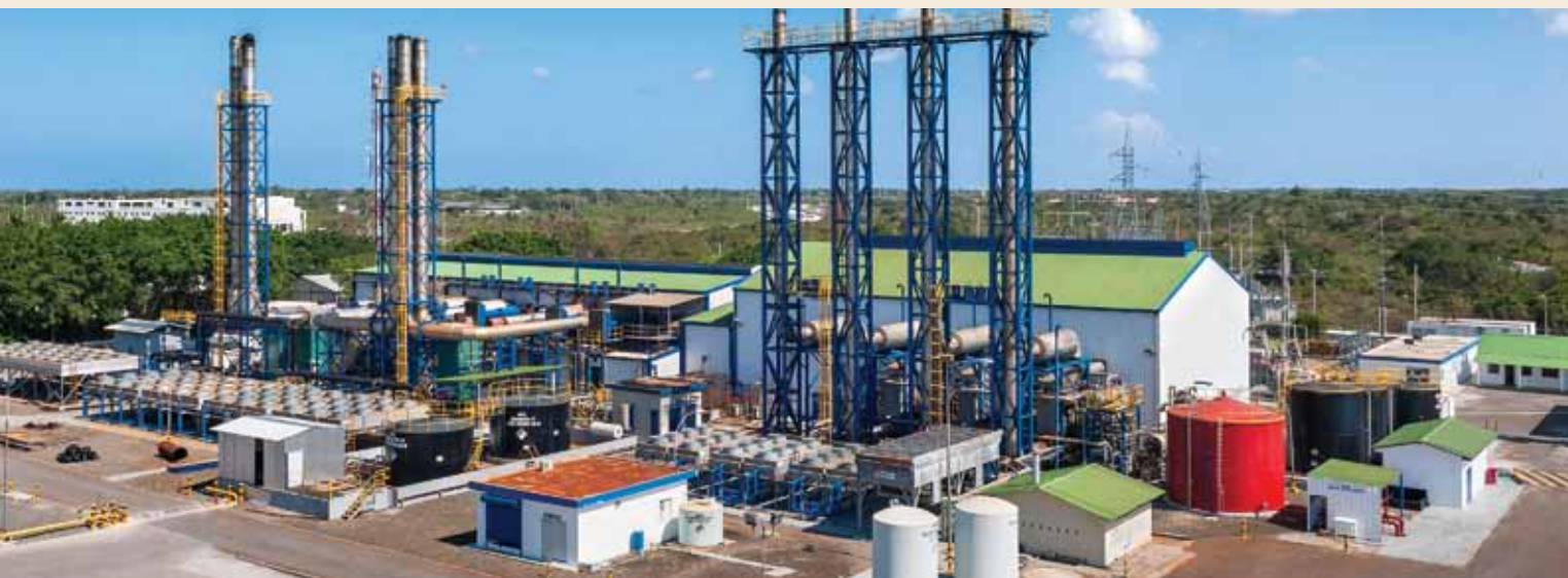
Existen 18 unidades disponibles en nuestra planta principal en Bávaro. There are 18 units available in our main plant in Bávaro.
